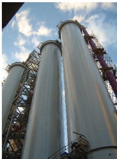
Torres: 70 m de altura e 7,2 m de diâmetro cada uma
