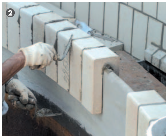
1 – Aplicação da camada protetora; 2 – Assentamento peças J; 3 – Topo de torre, calha sendo revestida no solo com peças J, torres ao fundo
