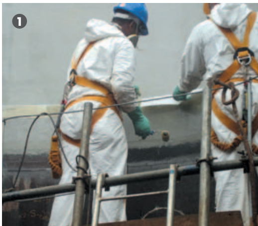
1 – Aplicação da camada protetora; 2 – Assentamento peças J; 3 – Topo de torre, calha sendo revestida no solo com peças J, torres ao fundo
