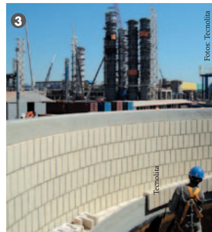
1 – Aplicação da camada protetora; 2 – Assentamento peças J; 3 – Topo de torre, calha sendo revestida no solo com peças J, torres ao fundo
